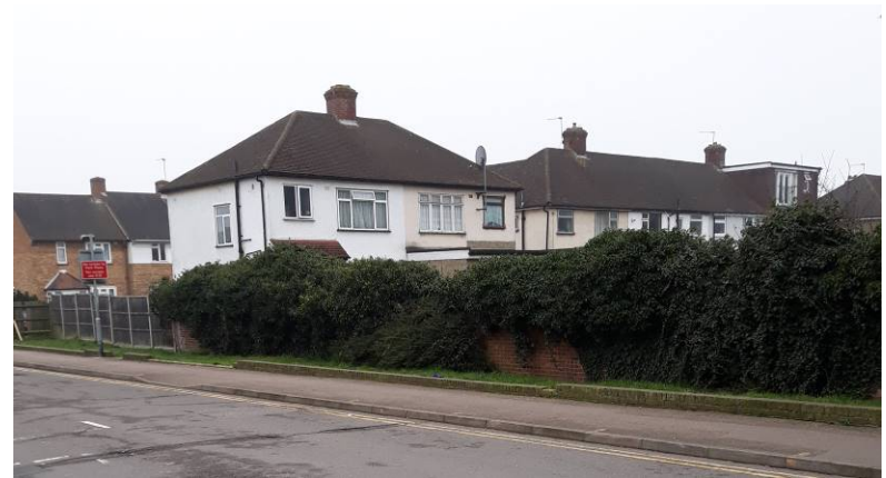
Figure 6 Rear of dwellings on Ruthven Av
